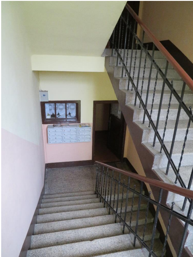
Ryc. 4. Powierzchnia stopni oraz spocznika na poziomie 0 wykonana z lastriko, „MUZEUM MIEJSCE PAMIĘCI – KL Plaszow” – Wykonanie inwentaryzacji, ekspertyzy konstrukcyjnej, badań architektonicznych oraz badań konserwatorskich dla budynku przy ul. Jerozolimskiej 3 w Krakowie, tzw. „Szarego Domu”, oprac. Perspektywa Pracownia Architektoniczna Sp. z o. o., 2017 r.
