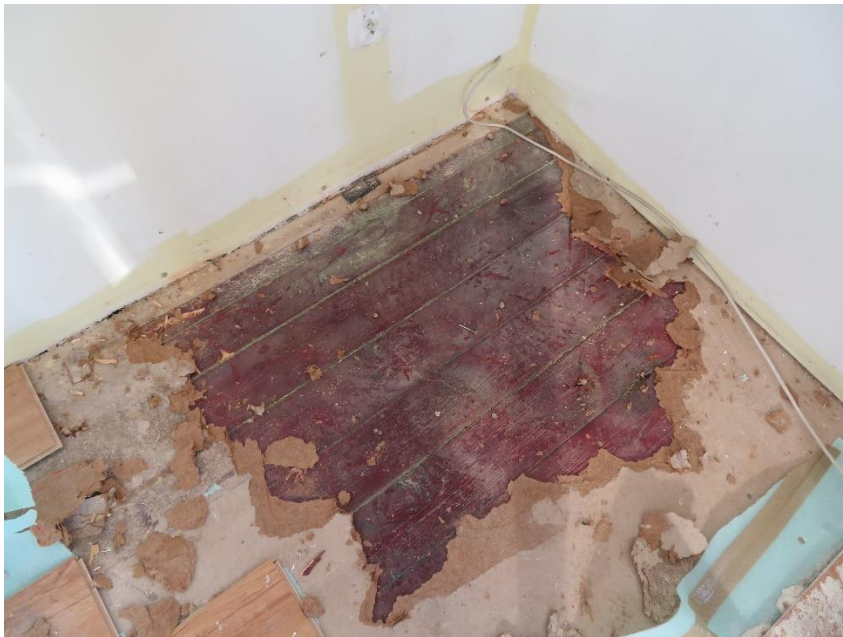
Ryc. 5. Zachowana drewniana podłoga w pomieszczeniu na piętrze budynku, „MUZEUM MIEJSCE PAMIĘCI – KL Plaszow” – Wykonanie inwentaryzacji, ekspertyzy konstrukcyjnej, badań architektonicznych oraz badań konserwatorskich dla budynku przy ul. Jerozolimskiej 3 w Krakowie, tzw. „Szarego Domu”, oprac. Perspektywa Pracownia Architektoniczna Sp. z o. o., 2017 r.
